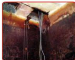
Dépôts fer - manganèse, photo C
